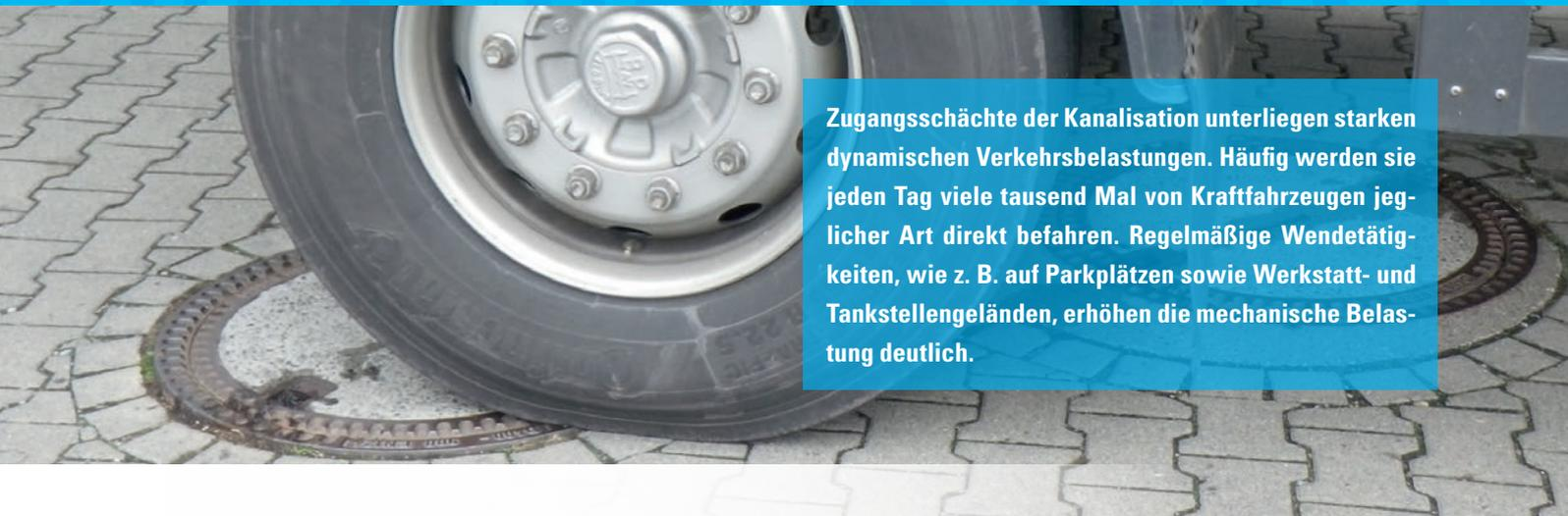
Zugangsschächte der Kanalisation unterliegen starken dynamischen Verkehrsbelastungen. Häufig werden sie jeden Tag viele tausend Mal von Kraftfahrzeugen jeglicher Art direkt befahren. Regelmäßige Wendetätigkeiten, wie z. B. auf Parkplätzen sowie Werkstatt- und Tankstellengeländen, erhöhen die mechanische Belastung deutlich.
