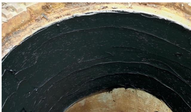
Schachthals, abgedichtet mit ombran flex
